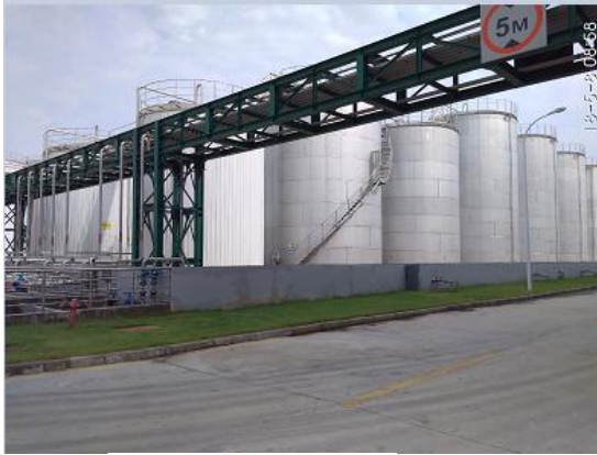
毛油罐区围堰
