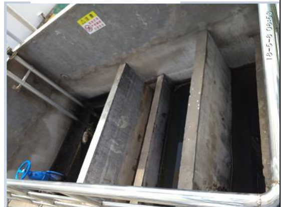
成品油罐区事故池
