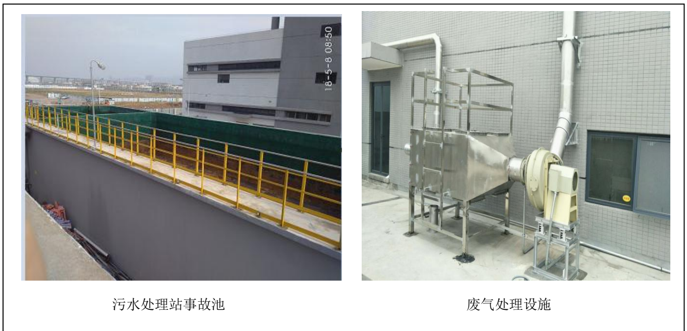
图 4-2 现场环保设施照片
