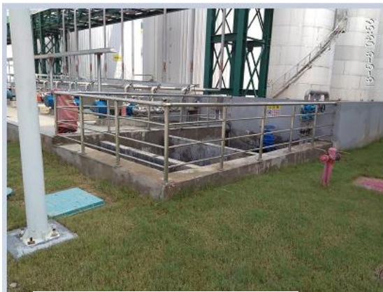
毛油罐区事故池
