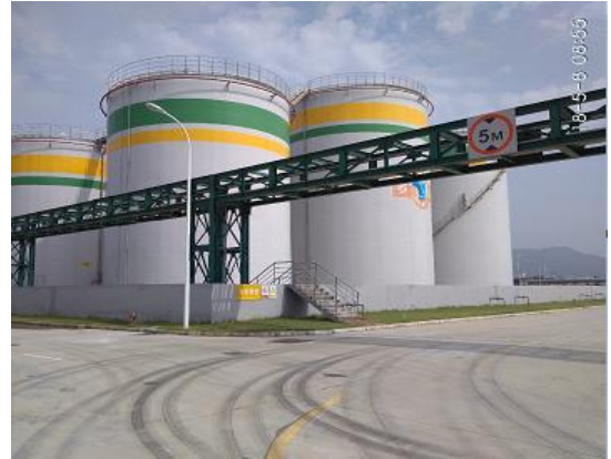
成品油罐区围堰
